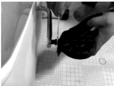
**ОЧЕНЬ ВАЖНО:** Пожалуйста, соблюдайте инструкцию шаг за шагом. Основание педали должно быть плотно закреплено, стопорная гайка также должна быть плотно закреплена. Периодически проверяйте, чтобы убедиться в надежности и прочности крепления.
